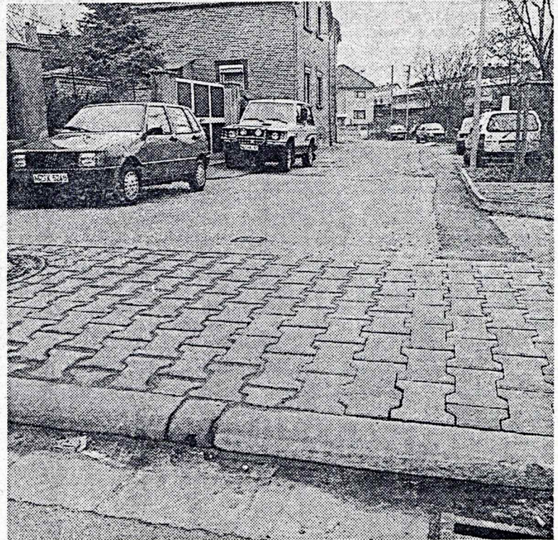
Die Straßenbauarbeiten für die Bahnhofstraße wurden im Rat vergeben. Bis zum Spätjahr sollen sie abgeschlossen sein. Bild: Volker Oehl
